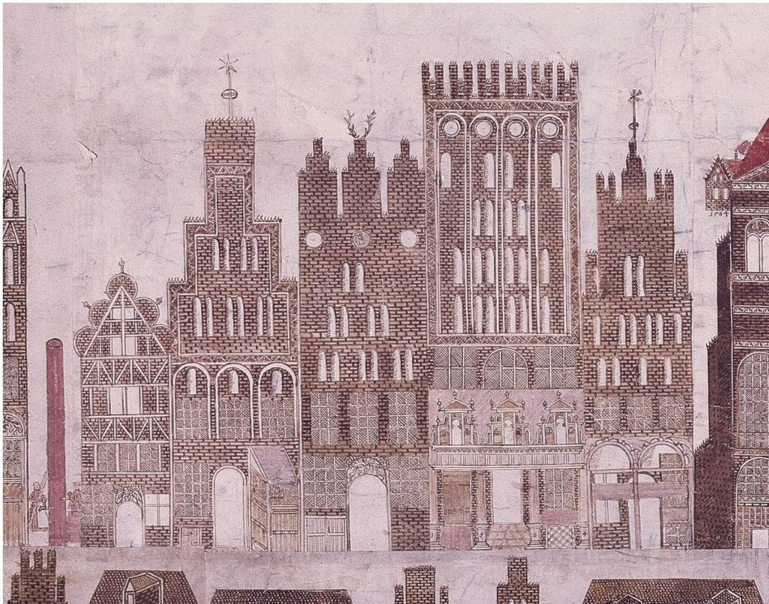
Die Vicke-Schorler-Rolle ist voller Details: Hausgiebel, Fassadendekorationen und Brunnen.
