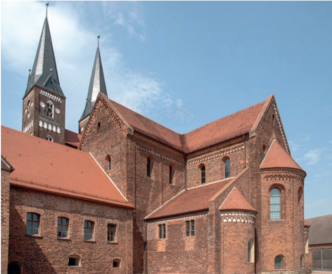
Abb. 4 Jerichow, Anlage des 1144 gegründeten Klosters, dessen Kir- che lange als ältester Backsteinbau in Nord- deutschland galt (Foto: Dirk Schumann)
